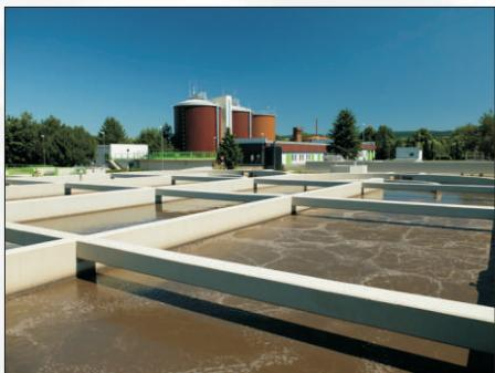
V letech 2012 - 2014 akciová společnost K&K TECHNOLOGY realizovala technologickou část projektu rekonstrukce ČOV Ústí nad Orlicí, jejímž provozovatelem je firma TEPVOS. Intenzifikaci ČOV bylo docíleno efektivnějšího zpracování odpadních vod zejména v odstranění organického znečištění, ale také znečištění tvořeného různými formami dusíku a fosforu. Současná navrhovaná kapacita čistírny je 22 000 EO.
